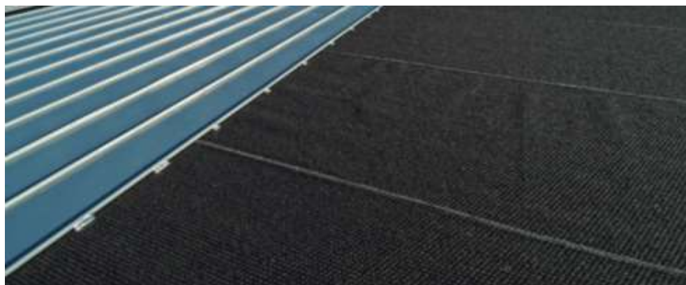
Рис. 5 DELTA-TRELA PLUS разделительный слой (ОДМ)
