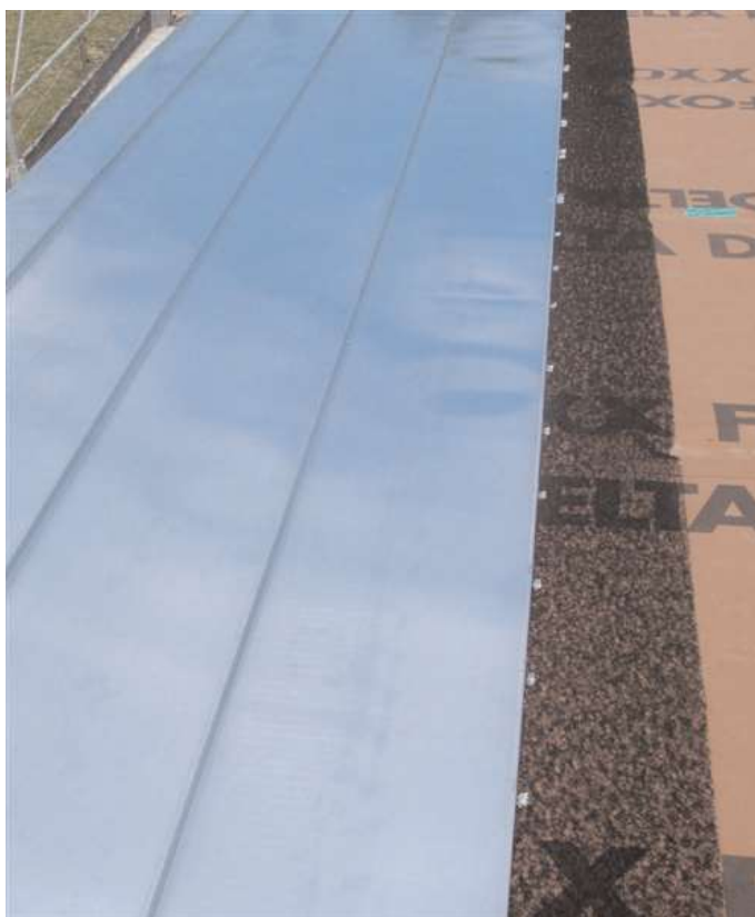
Рис. 6 Разделительный слой из комбинации диффузионной плёнки DELTA-FOXX PLUS и структурированного мата DELTA-Enka VENT
