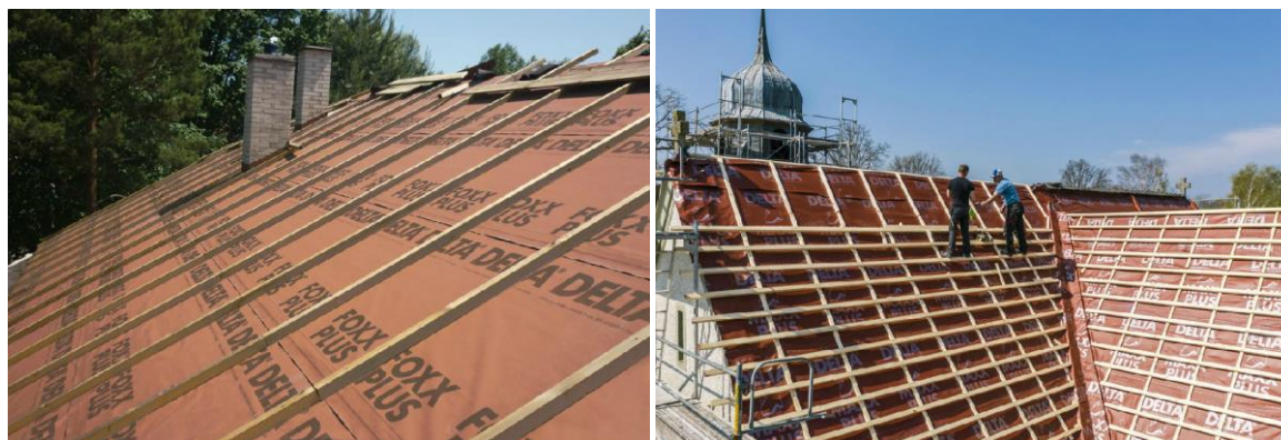
Рис. 5: Диффузионные мембраны под воздействием УФ излучения.
