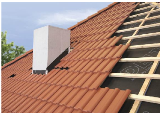
Рис. 6: в закрытом состоянии мембрана защищена от УФ-излучения, но не от тепла и движения воздуха в пространстве между покрытием и мембраной.
