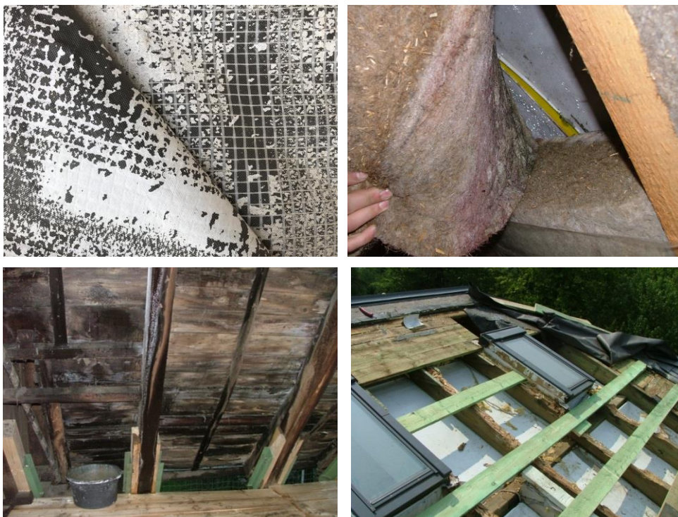
Рис. 2: Поврежденная из-за преждевременного старения мембрана (вверху слева) и последствия для конструкций крыши.
